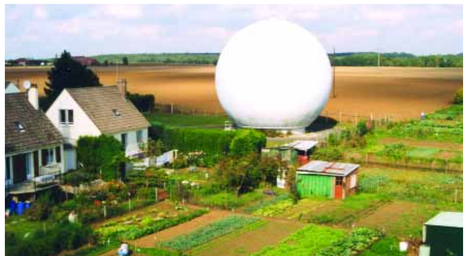
La sphère de réserve d'eau sera démontée par la Lyonnaise des eaux
